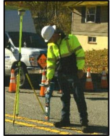
Fig. 22 Utilizando o localizador e o GPS para acompanhar a câmera sonda de CCTV
