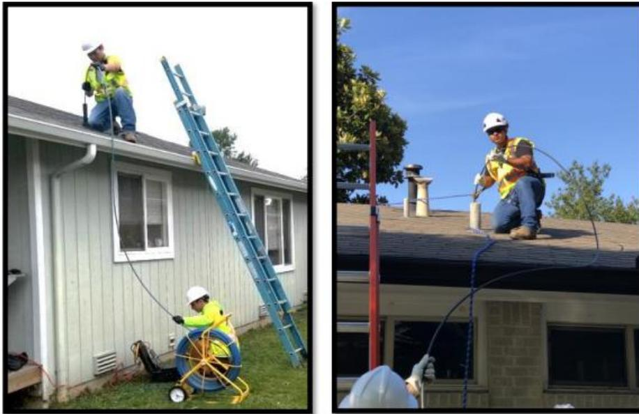
Figura 20: Inspeção com câmera rebocada pelo respiro. Eventualmente EPIs e parâmetros para quedas devem ser utilizados.
